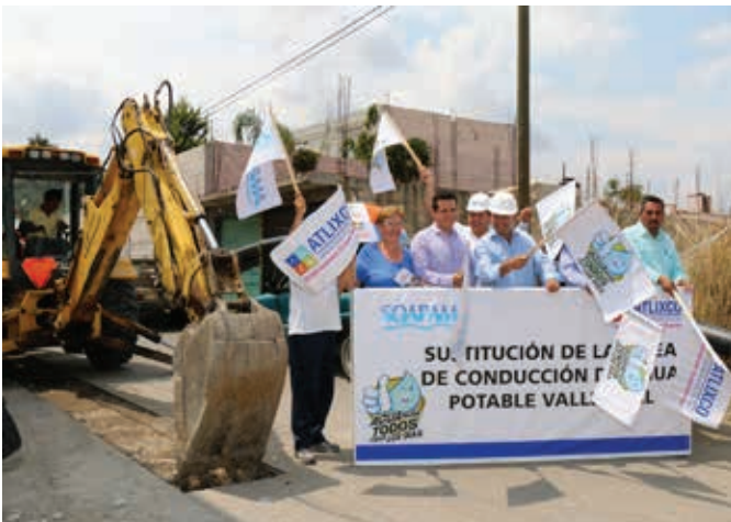
inicio de obra de agua potable
